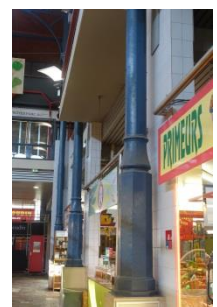
Les colonnes en fonte
