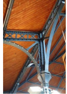
Entraits et arbalétriers
