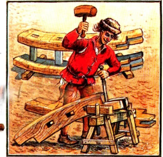
Le maître charpentier fabrique les cintres des voûtes et les charpentes.
