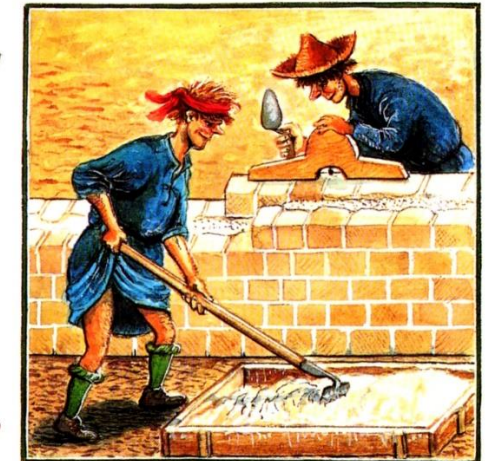
Le gâcheur prépare le mortier et le maçon assemble les pierres.
