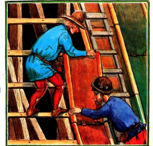
Le toit est souvent recouvert de plaques de cuivre.
