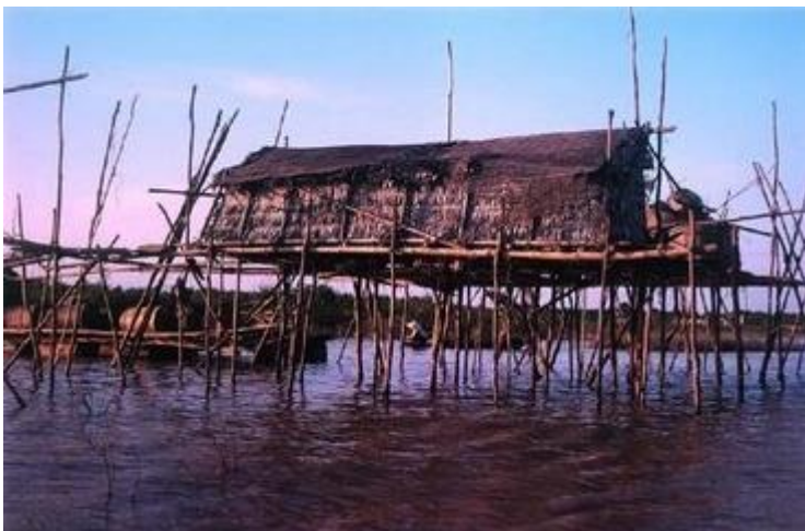
Maisons sur pilotis, Cambodge
